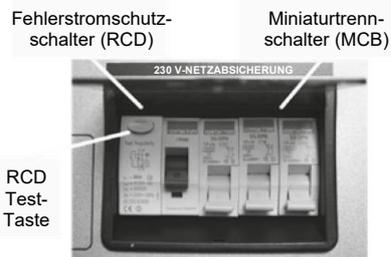
Der Fehlerstromschutzschalter (RCD) dient grundsätzlich dazu, den Benutzer gegen Stromstöße abzusichern. Der RCD wird ausgeschaltet (ausgelöst), wenn der im unter Spannung stehenden Leiter fließende Strom nicht vollständig zum Nullleiter zurückfließt, das heißt, wenn ein bestimmter Teil des Stroms durch eine Person zur Erde oder durch ein fehlerhaftes Gerät fließt.
